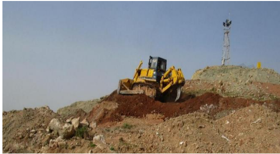
شکل (۵). نمایی از تسطیح و آماده‌سازی دپوی مصالح حفاری‌شده
