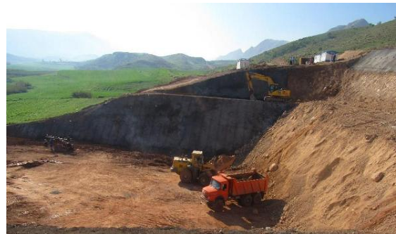
شکل (۴). نمایی از خاک‌برداری پرتال ورودی
