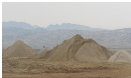
شکل (۷). مصالح رودخانه‌ای تهیه‌شده برای استفاده در کارگاه
