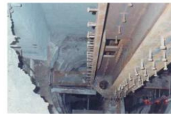
شکل (۲): اجرای تعدادی از ستون‌های به صورت شمع
