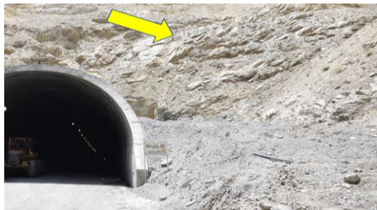
شکل (۱۰). شیب بندی لایه‌های اسلیتی تونل خوانسار
