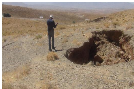
شکل (۱۵). محل ریزش تونل خوانسار
