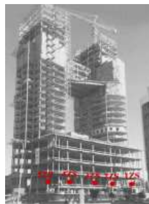
شکل (۷). نمای ساختمان زیبا سازه و محل نصب تیلترها
