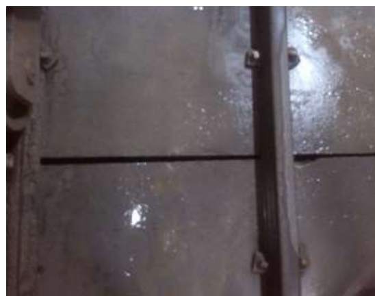
شکل (۱۲). ایجاد فاصله عمودی بین سگمنت‌های Invert در سمت بیرونی قوس جهت ایجاد قوس یکنواخت در ریل‌ها
