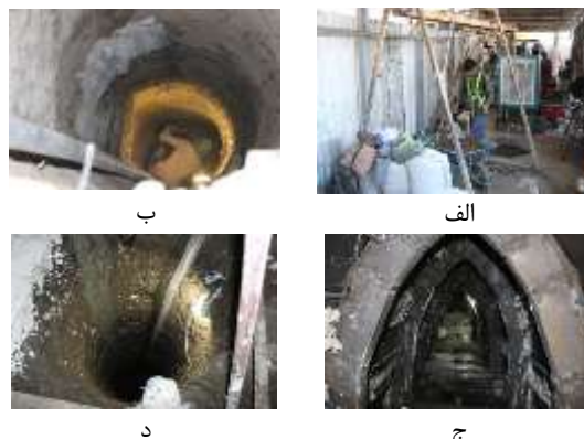
شکل (۹). (الف و ب): اجرای عملیات شمع‌های اصلی (دسترس)، (ج): اجرای گالری دسترسی شمع‌های ثانویه، (د): اجرای شمع‌های ثانویه
