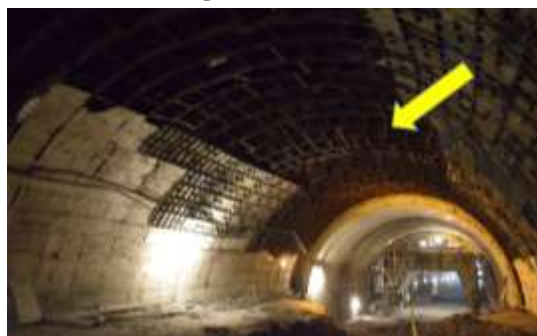
شکل (۱۷). تغییر شکل دادن قاب تونلی به دلیل تنش های روباره ای
