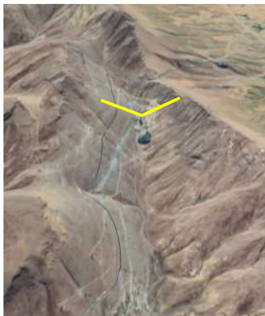
شکل (۶). دره اسلیتی پروژه تونل خوانسار
