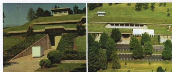
شکل ۱- نمونه ای از بام سبز ، ساختمانی اداری کولپیر در ویرجینیا [۴]
