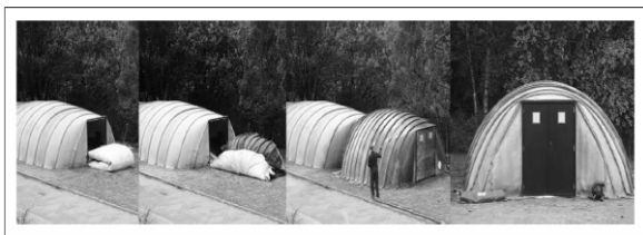
شکل (۲): برپاسازی چادر بتن پارچه‌ای [۲]
