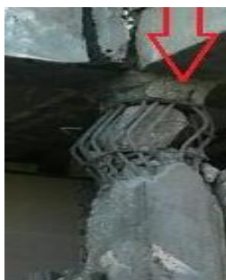
شکل (۱۸): عدم رعایت ضوابط و مقررات در مورد ستون‌های بتنی و فلزی
