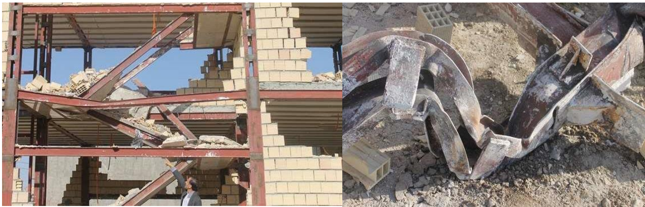
شکل (۴): کمانش و پیچش در تیر پیچش در ستون
