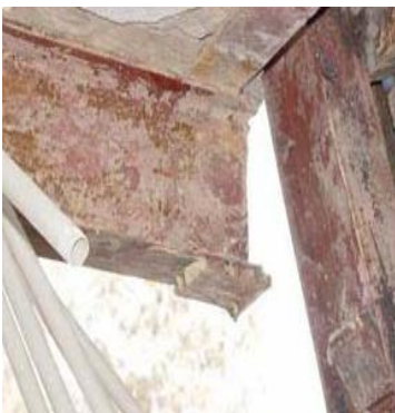
شکل (۷): اتصال نامناسب تیر به ستون
