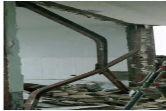
شکل (۱): کمانش در بادبند
