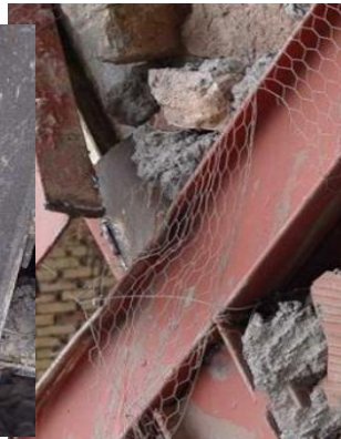
شکل (۶): اتصال نامناسب گاست پلیت مهاربند.
