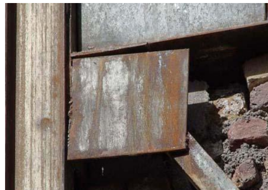
شکل (۵): نمونه ای از اتصال مناسب و نامناسب گاست
