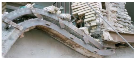
شکل (۱۸): عدم رعایت ضوابط و مقررات در مورد ستون‌های بتنی و فلزی
