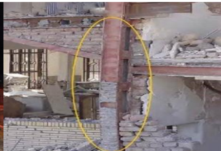
شکل (۳): کمانش در ستون و در بادبند در زلزله بم و کرمانشاه
