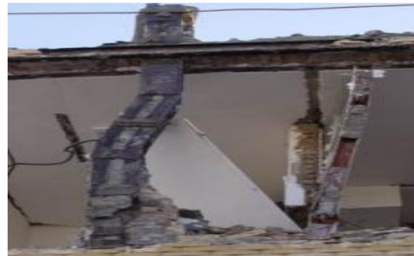
شکل (۲): کمانش در ستون
