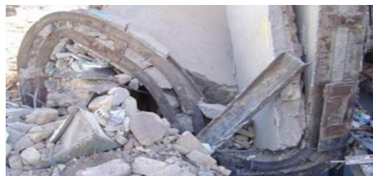
شکل (۱۹): فاصله زیاد قیدها جوابگو نبودن مقطع در برابر بار
