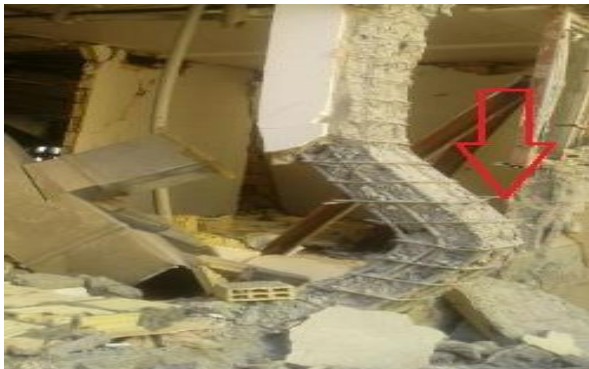
شکل (۲): کمانش در ستون
