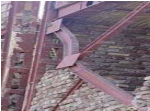
شکل (۱): کمانش در بادبند
