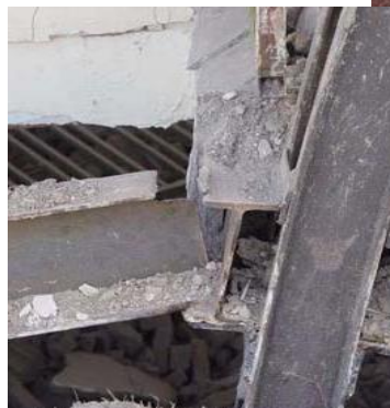
شکل (۷): اتصال نامناسب تیر به ستون
