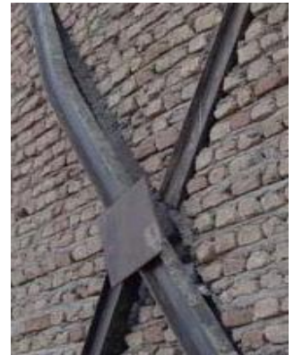
شکل (۶): اتصال نامناسب گاست پلیت مهاربند.
