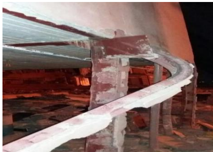
شکل (۳): کمانش در ستون و در بادبند در زلزله بم و کرمانشاه
