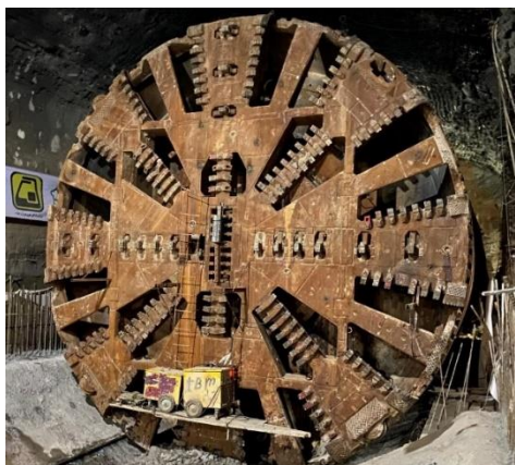
شکل (۱). ماشین EPB شرکت مهندسی سابیر بین‌الملل توسعه جنوبی خط ۶ مترو تهران
